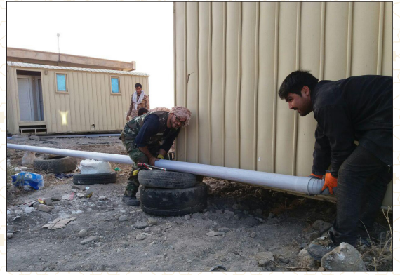
لوله کشی سرویس بهداشتی و حمام عمومی
