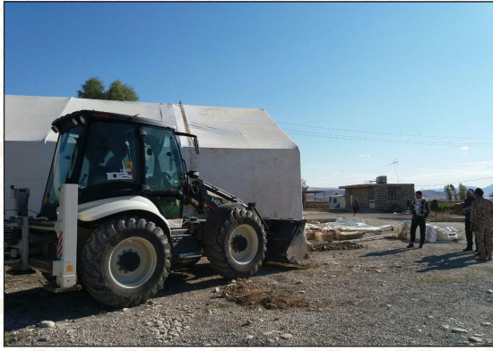
لوله کشی سرویس بهداشتی و حمام عمومی
